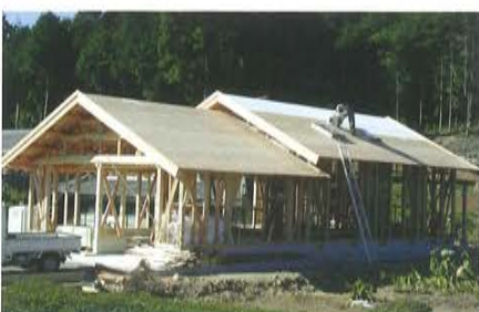
瓦屋根家屋の野地板に塗布。
