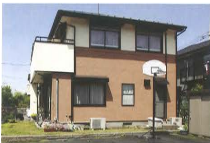
O邸：塗布箇所/屋根：90.9㎡、外壁：156.95㎡。
