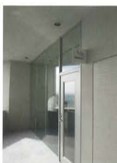
喫煙室の内壁に塗布。
