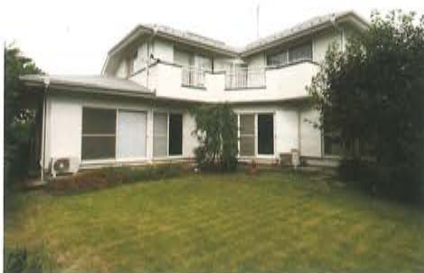
M邸：塗布箇所/屋根：130㎡、外壁：140㎡。
