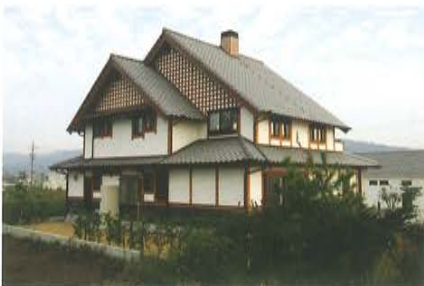
T邸：塗布箇所/屋根：300㎡、外壁：180㎡他。
