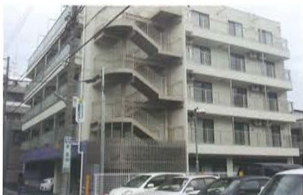
老人ホームの屋上・外壁に塗布。
