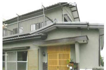
K邸：塗布箇所/内壁・天井：40㎡、外壁：260㎡。
