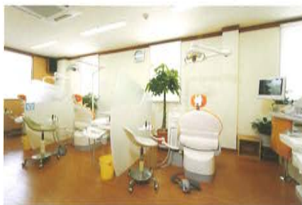
F歯科医院：塗布箇所/内壁・天井：168㎡。
