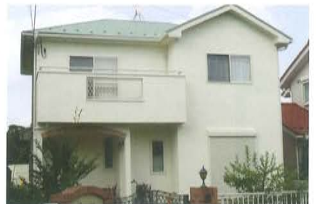
S邸：塗布箇所/屋根：94㎡、外壁：140㎡。
